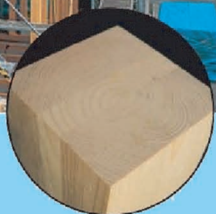
●集成材柱 (反り、ひび割れに強い)
