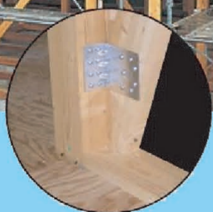
●ビス止め筋かい金具 (筋かいと柱の接合)
