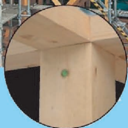
●ドリフトピン接合 (柱と梁の接合)
